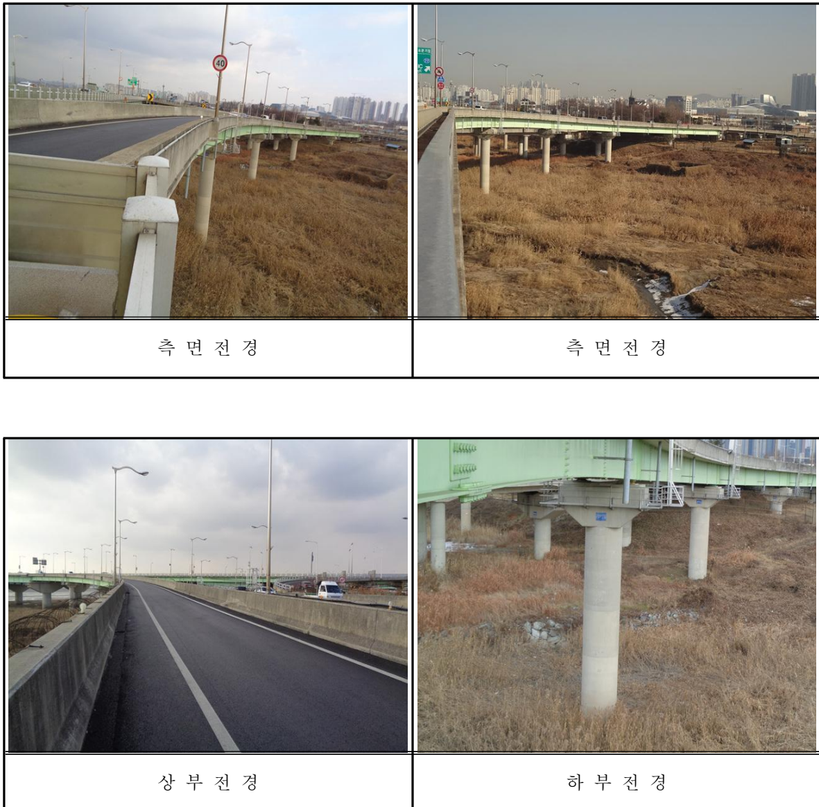
【이산포IC RAMP-G교 전경】
