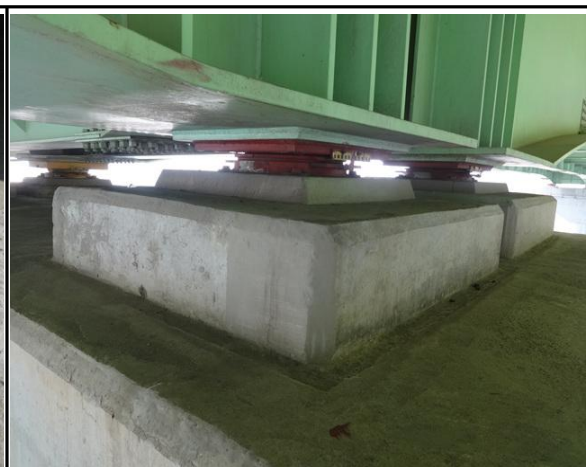
일산방향 P23-SH3 받침콘크리트 철근노출 보수
